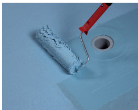
Nanášení druhé vrstvy Mapelasticu AquaDefense válečkem
