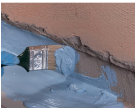
Nanášení Mapelasticu AquaDefense před instalací Mapebandu ve styku stěna-podlaha
